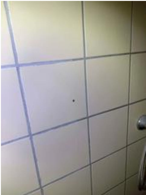
Eksempelbilde av eldre monteringshull i våtsone.
