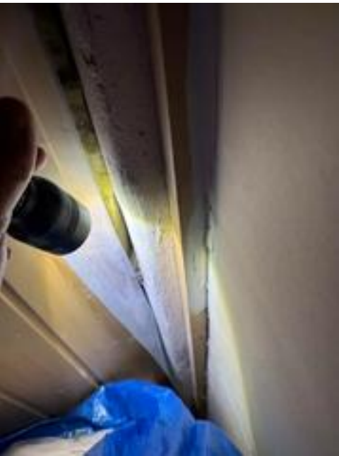
Eksempelbilde av utett dampspærre.
