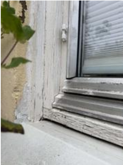
Eksempelbilde av slitasjegrad.
