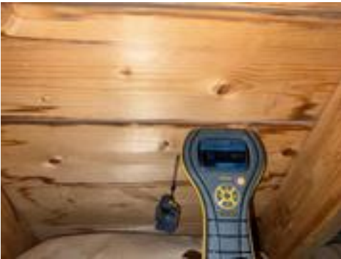
Det viser ikke unormale utslag på fukt ved fuktmåling.
