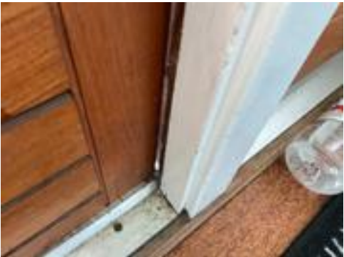
Dørbladet på hovedytterdøren klemmer ikke mot karm.
