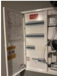
Sikringskap med automatsikringer
