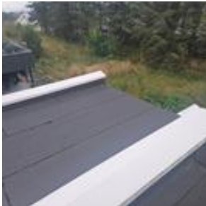
Taket er tekket med asfaltpapp
