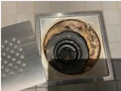
Plastsluk med slukmansjett og klemring
