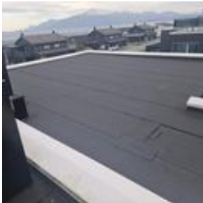
Taket er tekket med asfaltpapp
