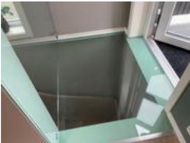
Glassplate i gulvet i 2 etg
