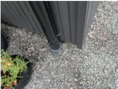
Takkvannet ledes til rør i grunnen
