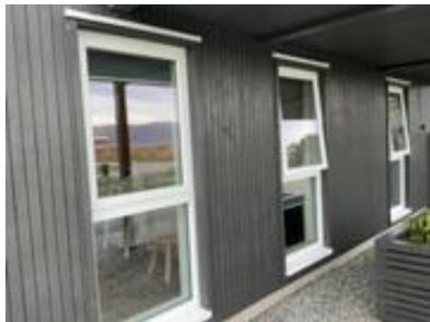
Vinduer med karmen av pvc
