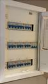
Sikringskap med automatsikringer
