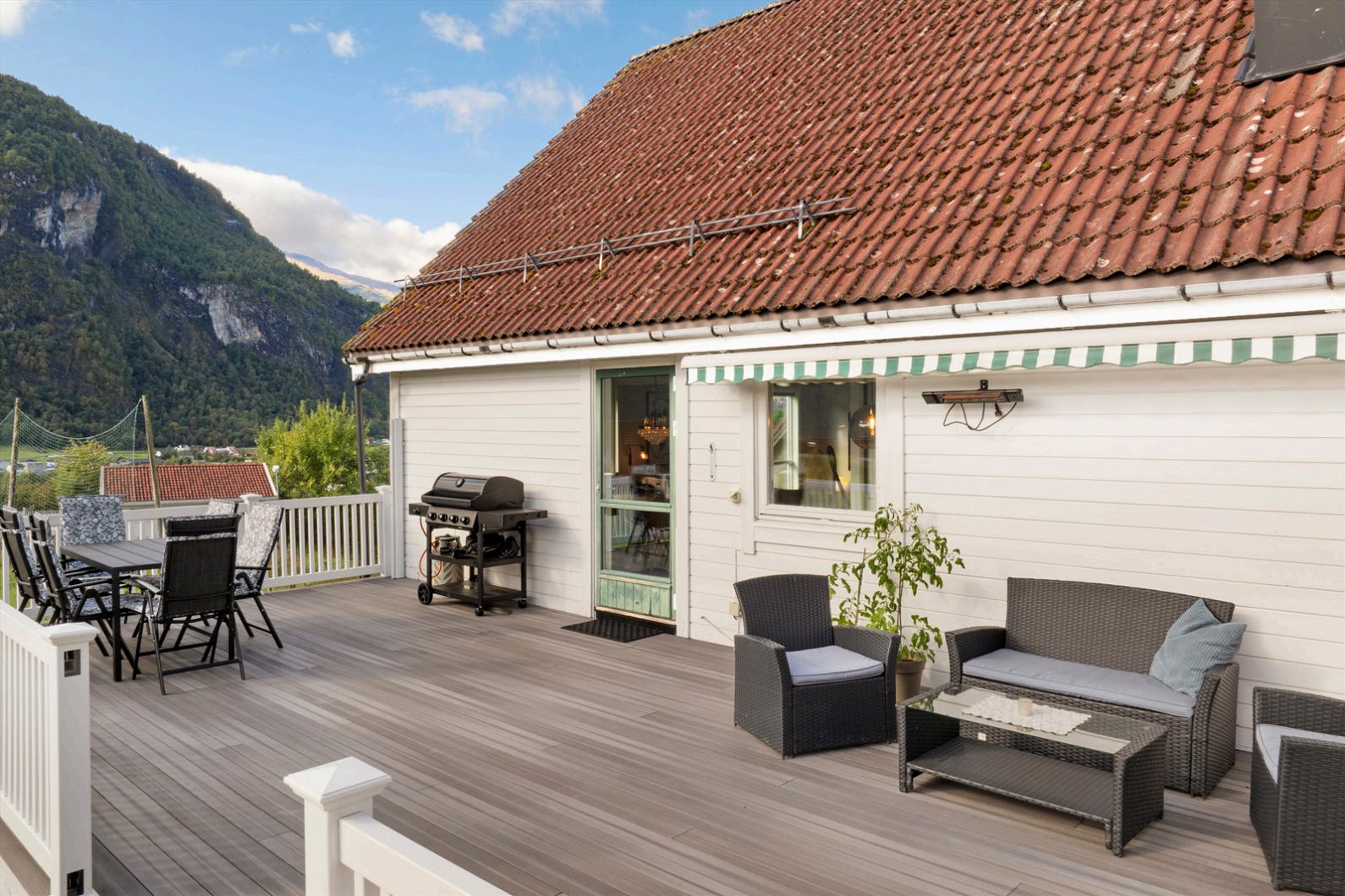
Terrasse utanfor stova bygd på betongfundament med trekonstruksjonar og komposittgolv.
