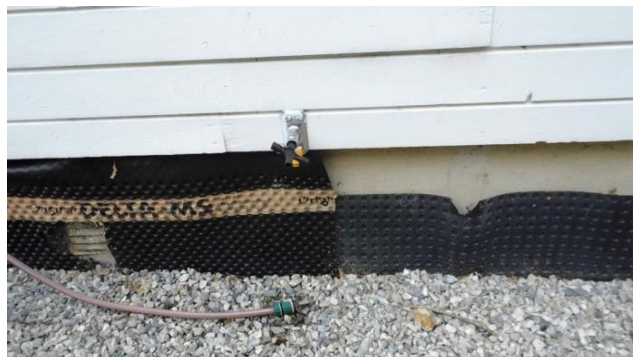
Grunnmursplast mot øst.
