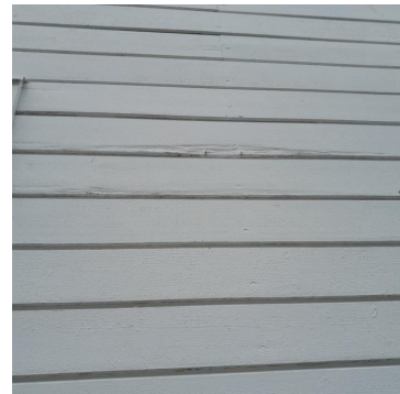
Råteskader i klædningen
