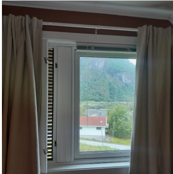
En del vindu har lufteluke ved siden av vinduet.
