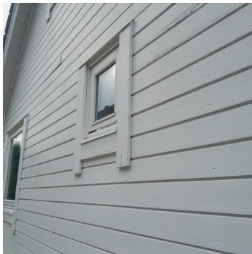
Utv vindu med vannbrett over og under.
