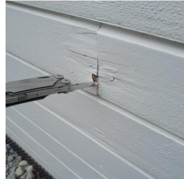
Råteskader i klædningen
