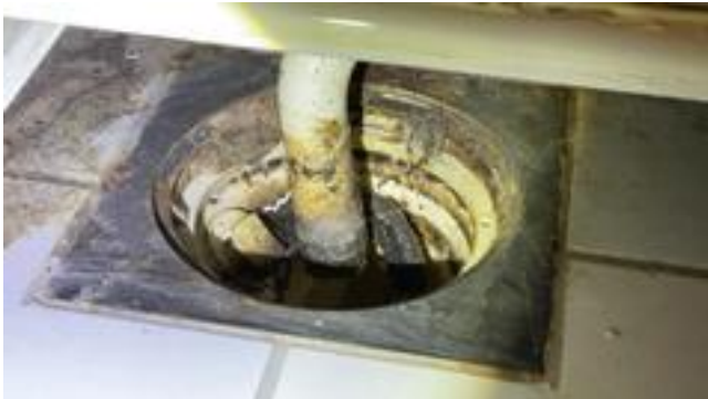
Sluk i gulv.
