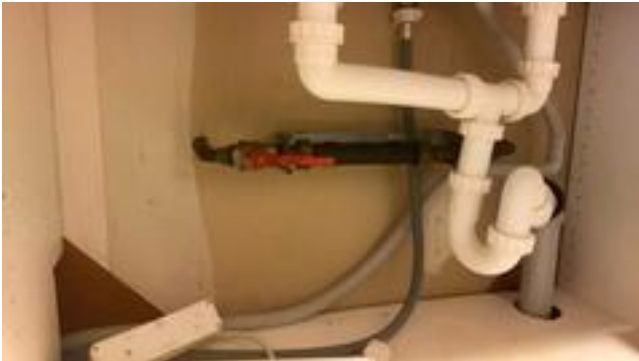
Stengekran på vann.
