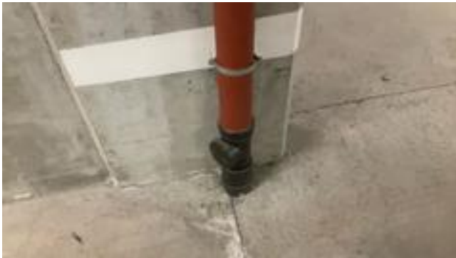
Stakemulighet på anlegget sett i kjeller.
