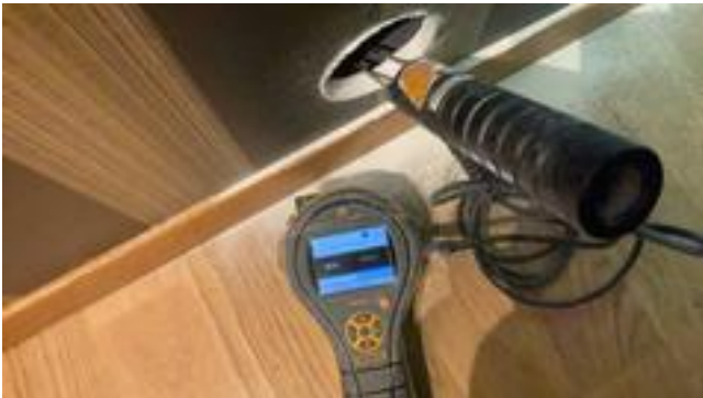
Fuktsøkt i vegg uten unormale forhold.
