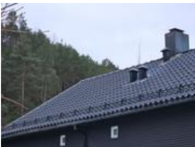
Taket er tekket med profilerte stålplater
