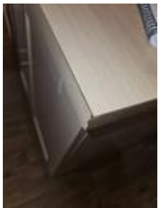
Skade på kanten på en benkeplate
