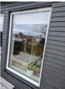
De fleste vinduene har karmen av pvc og isolerglass.
