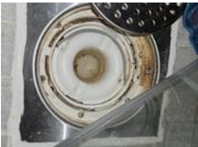
Plastsluk med mansjett og klemring
