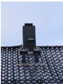
Pipetekk og luftehatter av metall
