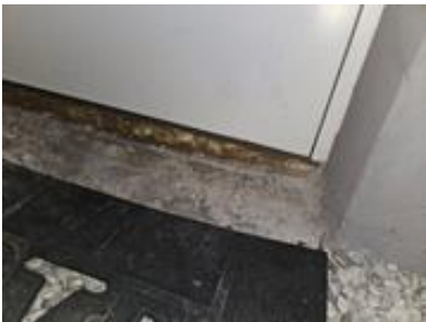
Ikke plastisk fuge eller beslag under kjellerdøren
