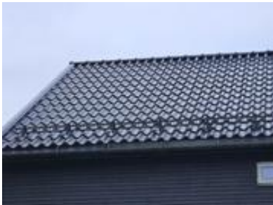
Snøfangere langs takfoten
