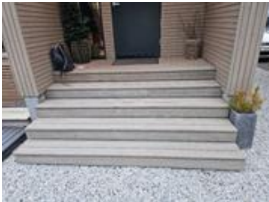
Trapp til inngangspartiet
