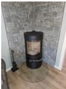
Vedovn og forblendet pipe / brannmur på stuen
