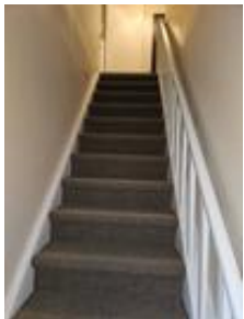
Innvendig trapp av tre mellom etasjene.
