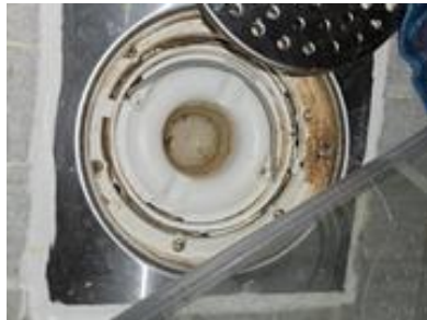
Plastsluk med mansjett og klemring
