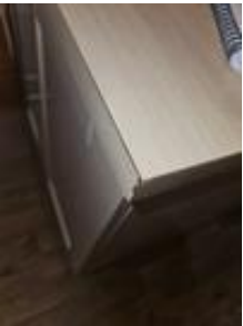
Skade på kanten på en benkeplate
