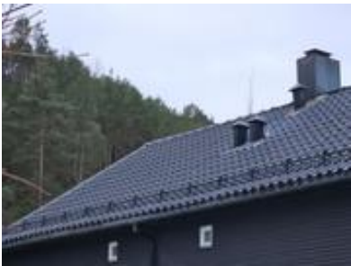
Taket er tekket med profilerte stålplater
