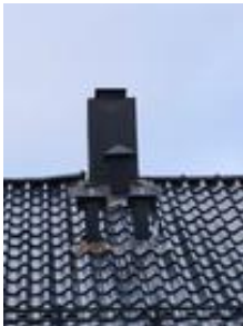
Pipetekk og luftehatter av metall
