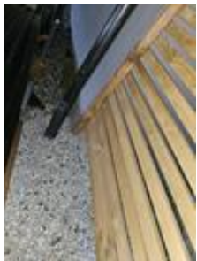
Takvannet ledes til rør i grunnen
