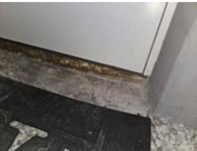
Ikke plastisk fuge eller beslag under kjellerdøren
