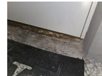
Ikke plastisk fuge eller beslag under kjellerdøren
