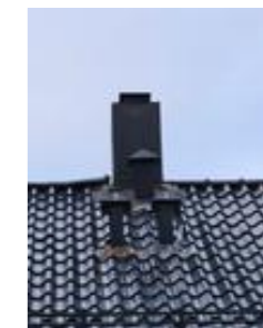
Pipetekk og luftehatter av metall
