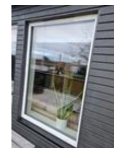
De fleste vinduene har karmen av pvc og isolerglass.
