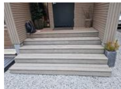
Trapp til inngangspartiet
