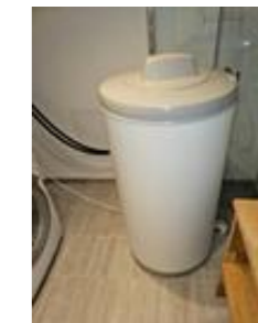
Varmtvannstank, ca 200 liter
