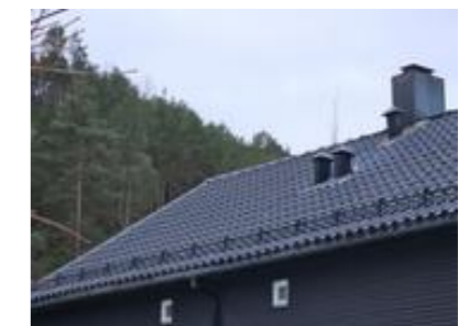
Taket er tekket med profilerte stålplater
