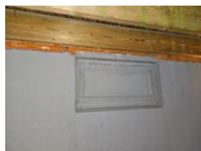
Tettet mellom grunnmur og yttervegg med fugesku
