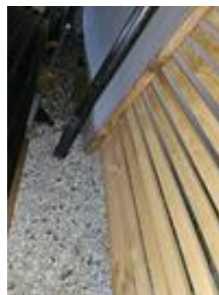
Takvannet ledes til rør i grunnen
