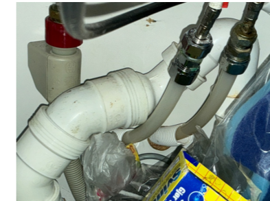
Skal være fug/tettemuffe mellom vannrør og hvitt varerør.
