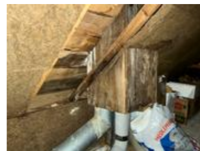
Eldre fuktskjolder rundt luftelyre.
