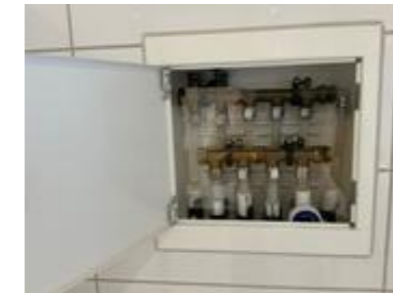
Skal være fug/tettemuffe mellom vannrør og hvitt varerør.
