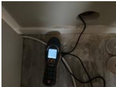
Bilde av fuktsøk uten at det påvises fukt.
