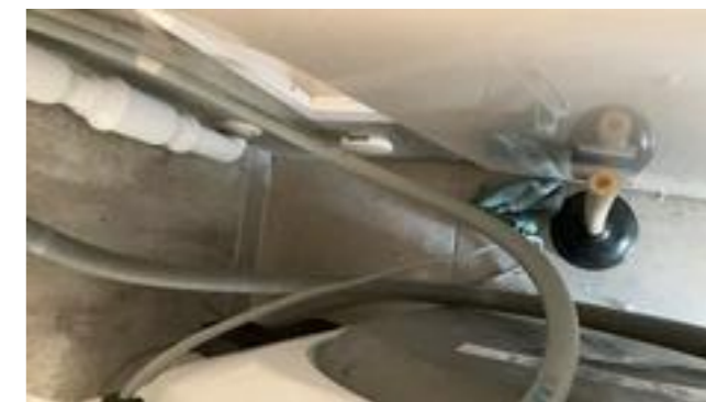
Dreneringsåpning fra vannskap
