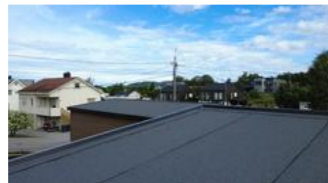
Taket er tekket med asfaltpapp
