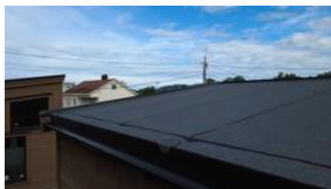
Taket er tekket med asfaltpapp
