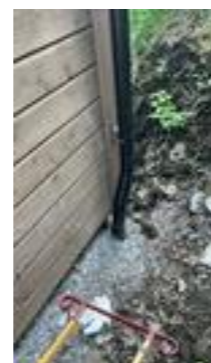
Takvannet ledes til rør i grunnen
