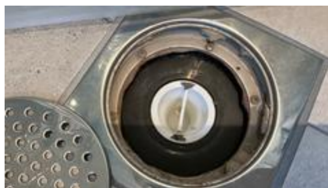
Plastsluk med mansjett og klemring
