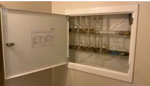
Vannfordeling for rør i rør.
