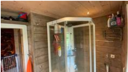
Baderom har trepaneler på vegg i våtsone for dusjnische.
