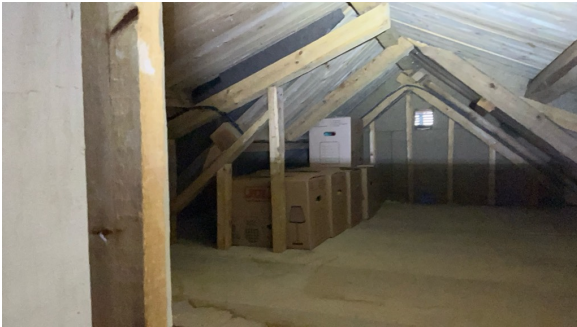
Takkkonstruksjon med bærende åser.
