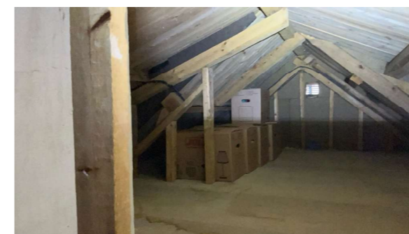
Takkonstruksjon med bærende åser.
