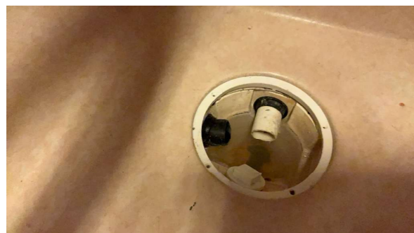
Sluk i vaskerom.
