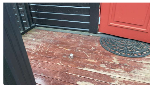
Liten avstand til underkant bordkledning.
