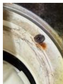
Ufagmessig bruk av skruer i klemring
