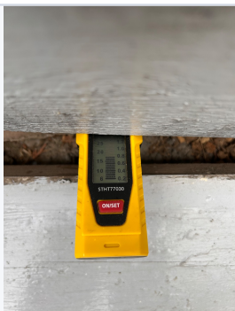
Målt fukt på 17% i laft bak kledning.
