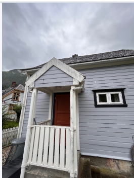
Målt fukt på 17% i laft bak kledning.
