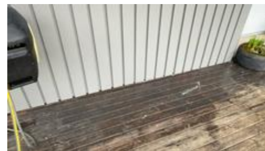
Terrassegulv er montert utenpå kledning.
