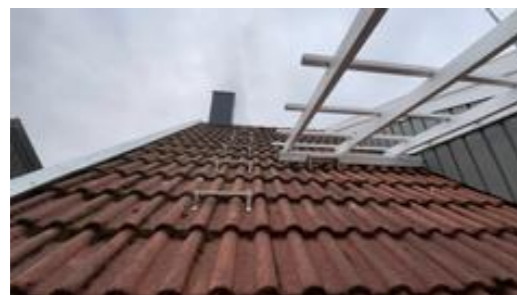
Taket er tekket med betongtakstein fra byggeåret.
