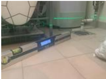
Bildet viser flatt gulv uten fall.
