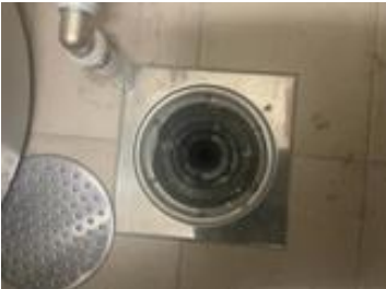
Oversiktsbilde av sluk.
