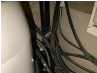
Stakeluke på anlegget.
