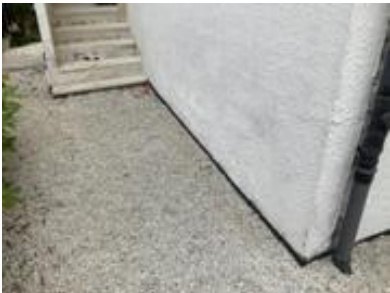
Terreng med lite eller ikke tilstrekkelig fall fra mur.
