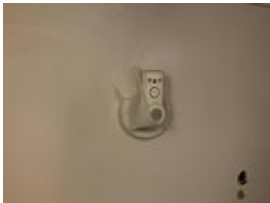
Vifte funksjonstestet med papir.
