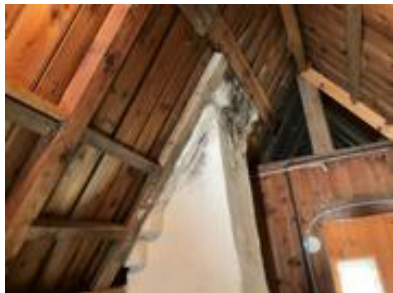
Pipe ved takgjennomføringen.
