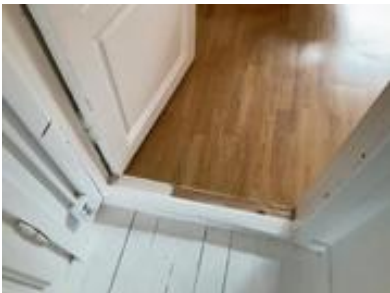
Bruksslitasjer/høvlet terskel.
