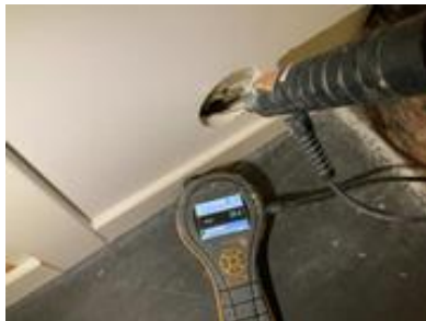
Fuktsøkt i vegg uten unormale forhold.
