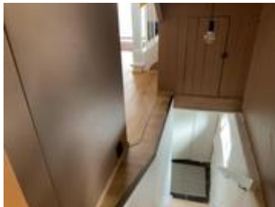
Ingen rekkverk på trapp til kjeller.
