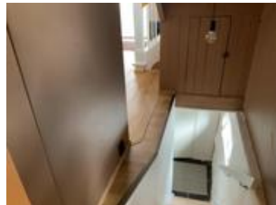
Ingen rekkverk på trapp til kjeller.
