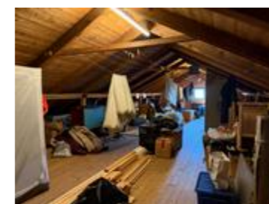
Uisolert ca 1/2 part av stort lagringsloft
