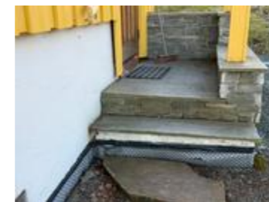
Manglende rekkverk i fellestrappen
