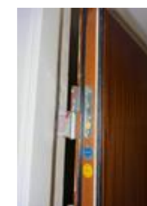
Malt/finert B-30/35dB dør inn til seksjonen.
