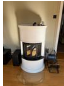
Elementpeis med innsats i stue.
