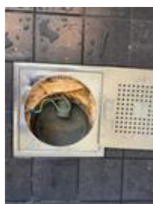
Hjelpesluk i dusjsone-usentrert sluk.
