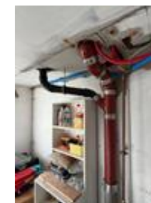
Plast og MA rør opp til badet-samt eldre rør i kjeller
