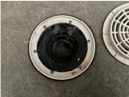
Oversiktsbilde av sluk.
