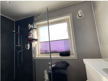
Bildet viser vindu som er plassert i dusjens våtsone
