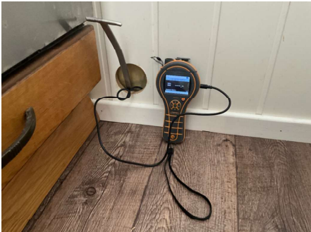
Fuktmåling uten utslag.
