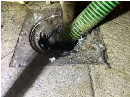
Oversiktsbilde av sluk.
