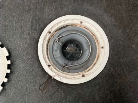
Oversiktsbilde av sluk.
