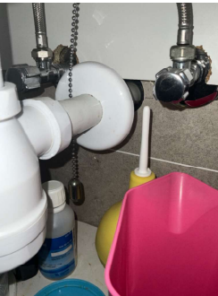
Bildet viser manglende tetting rundt rørgjennomføring i vegg.
