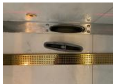
Sluket i dusjsonen.
