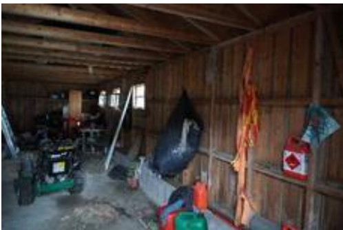
Foto 6: Uthus, samme nivå terreng inne-ute.
