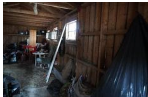
Foto 9: Uthus, bindingsverk uten skader..
