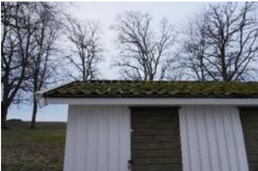
Foto 30: Uthus, vedlikehold av tekking..
