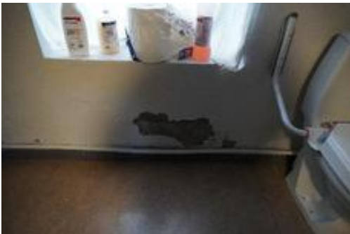
Foto 4: Ingeniørgården, fuktoppsug fra grunn.
