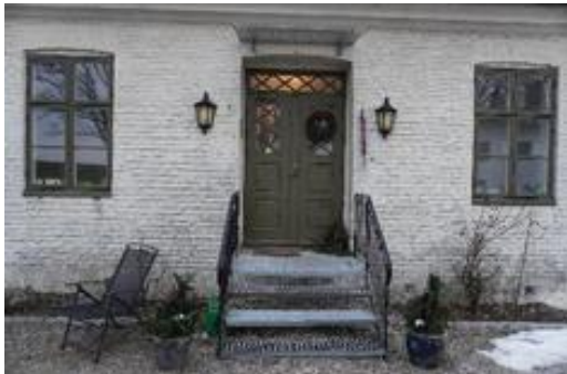
Foto 17: Vollmesterboligen, vedlikeholdt ytterdør.
