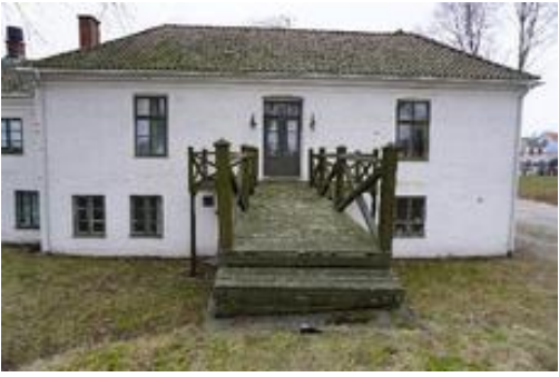
Foto 28: Ingeniørgården, vedlikehold av tekking..
