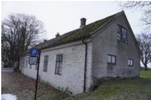
Foto 29: Voldmesterboligen, vedlikehold av tekking.
