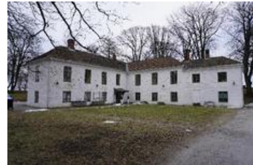
Foto 1: Ingeniørgården, registrert noe setninger.
