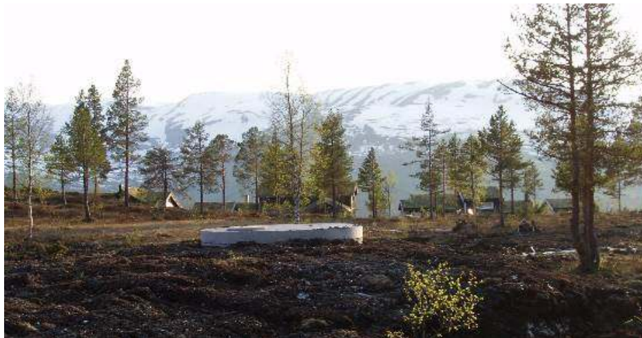
Figur 5.14.1: Biletet viser brønn/høgdebasseng på Litrane
