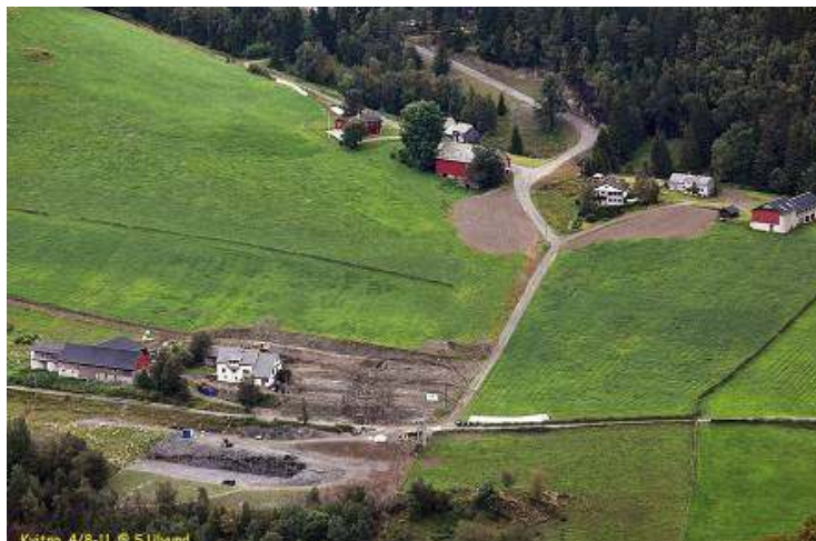
Figur 5.11.1: Grunnarbeid for tilrettelegging av husdyrparken starta opp sommaren 2011 (Foto: Svein Ulvund)
