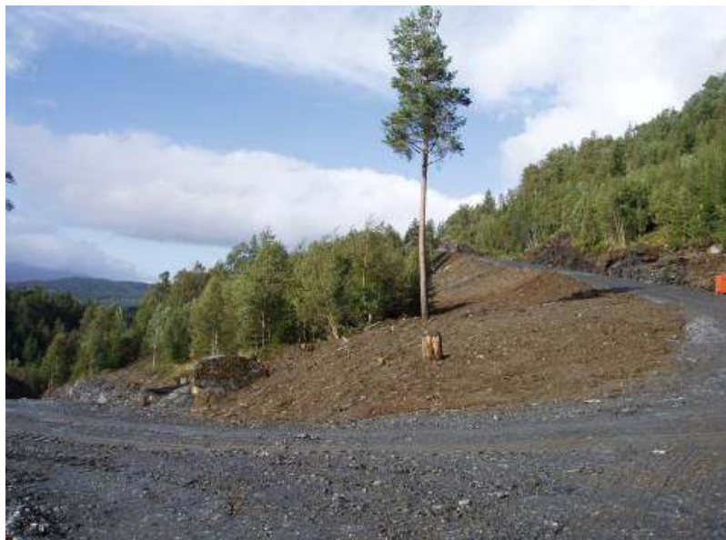
Figur 5.10.2: Kvitnamarksvegen, ca 2,5 km, går fra Fv.310 og opp til hyttefeltet. Infrastruktur som VA-leidninger og høgspenkabel er ført fram til hyttefelt langssette vegen.
