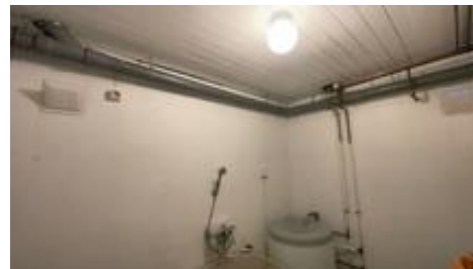
Mye synlig røropplegg.
