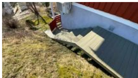
Manglende rekkverk.
