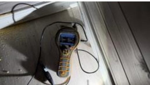
Bilde viser fuktmåling (rf-måling) i påforet vegg mot terreng.
