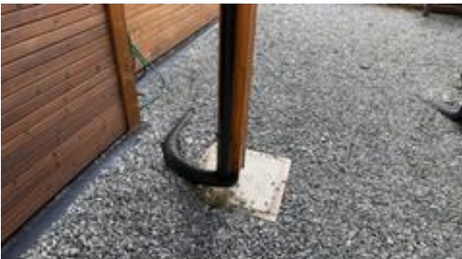
Bilde viser hvor det er benyttet perforerte drenersør for drenering av takvann.
