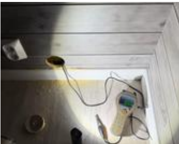
Bilde viser fuktmåling (vektprosent) i påforet vegg mot terreng.
