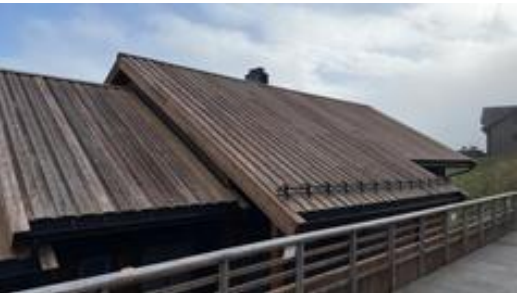
Oversiktsbilde som viser deler av taktekkingen.
