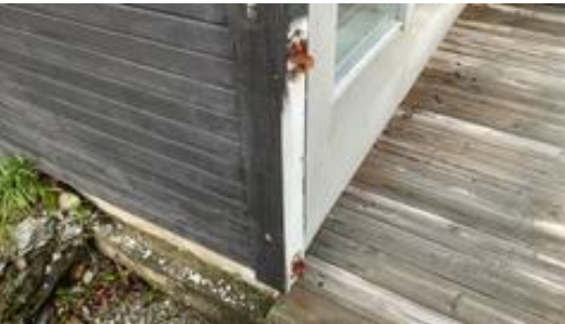
Magert/uferdig behandlet bygningsdeler.
