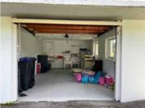
Eksponert isolasjon i himling/ tak
