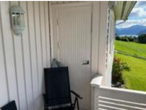
Dør som er bygget inne fra innsiden
