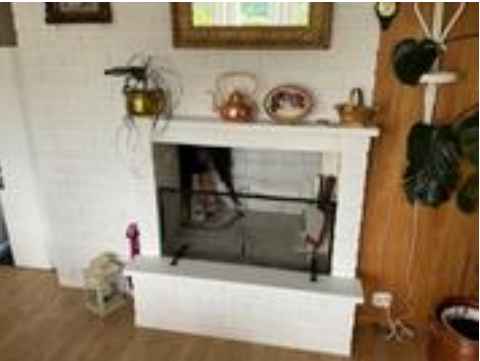
Mangler ubrennbar plate foran ildsted.
