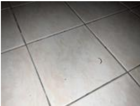
Hullrom under flis med slitte fuger.
