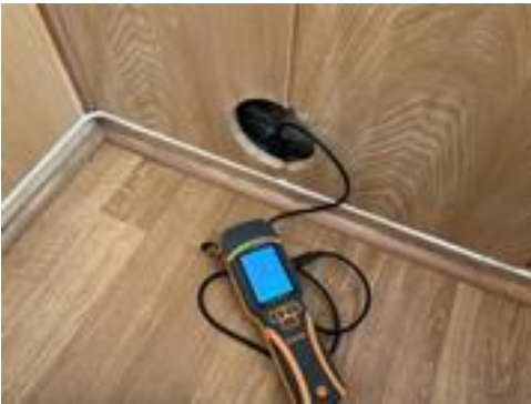
Fuktkontroll i påforingsvegg
