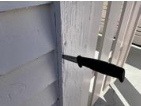
Råteskade observert
