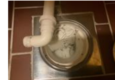
Oversiktsbilde av sluk.
