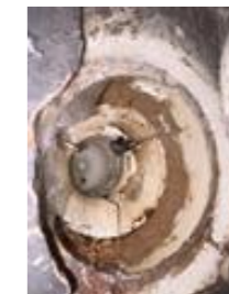
Bildet viser fallforholdet på gulv i dusj som er målt til 4 mm/m.
