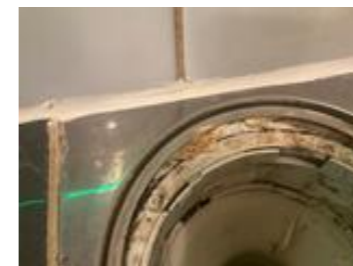
Bildet viser tettesjikt som er avsluttet over slukens klemring.
