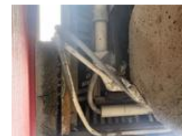
Bildet viser åpninger i musesperren.
