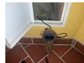
Fuktmåling uten utslag.
