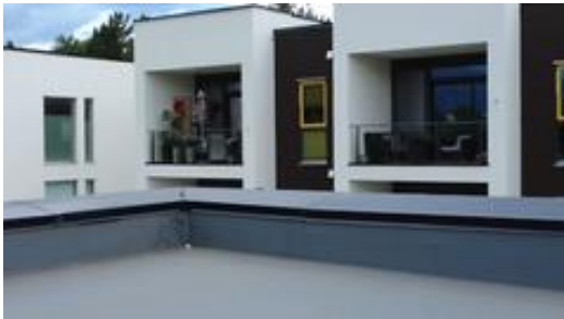
Parapet med beslag
