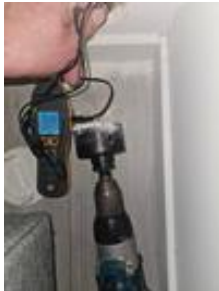
Ingen indikasjon på unormal fukt i veggen
