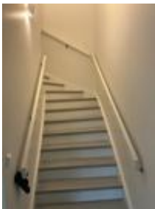
Innvendig trapp av tre mellom etasjene.
