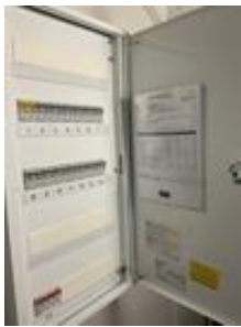
Sikringskap med automatsikringer og kursfortegnelse
