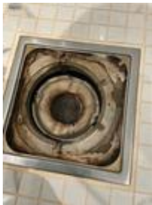
Plastsluk med mansjett og klemring
