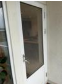
Verandadør med karmen og dørblad av pvc
