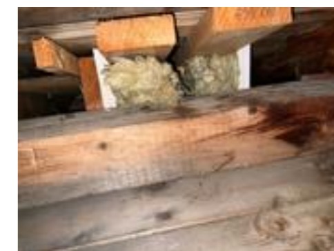
Toppen av skillevegg mot nabo.
