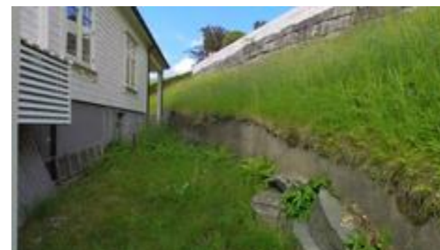
Terrengtet heller inn mot grunnmur.
