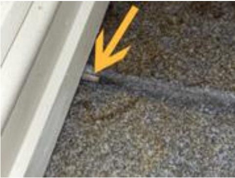
Stedvis er fugene slitt/ borte.
