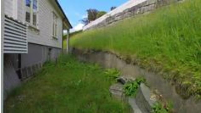
Terrengtet heller inn mot grunnmur.
