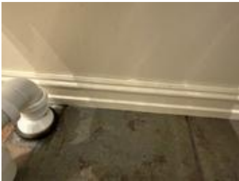
Gulvlist langs gulvet er ikke en godkjent løsning.
