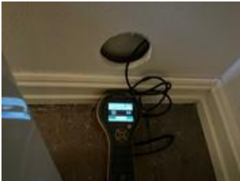
Fuktmåling. Ikke observert forøyede fuktverdier.
