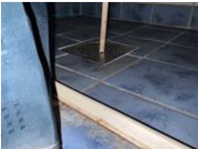
Lite fall til sluk. Tettelist på gulv til dusj.
