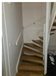
Innvendig trapp av tre mellom etasjene.
