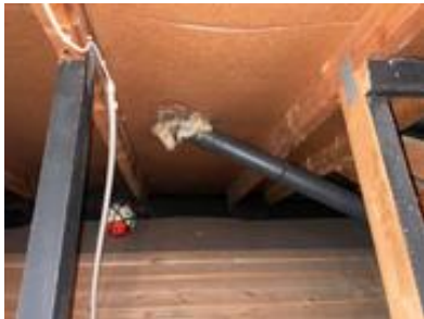
Uisolert kloakklufting.
