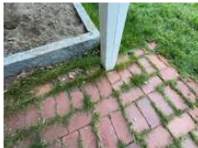
Søyler under overbygg på sørside, står ned i terreng og direkte på mur
