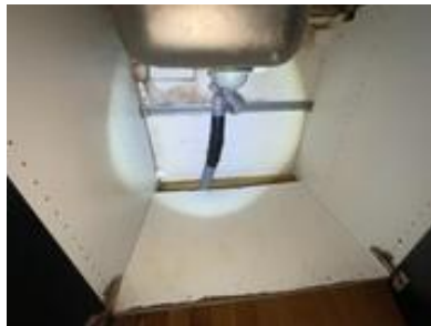
Avløp fra kjøkkenvask er tapet.
