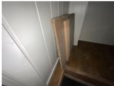
Uisolert luke til kryp kjeller.
