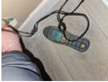
Ingen indikasjon på unormal fukt i vegg
