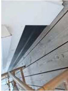
Ikke beslag mellom veranda-dekket og ytterveggen
