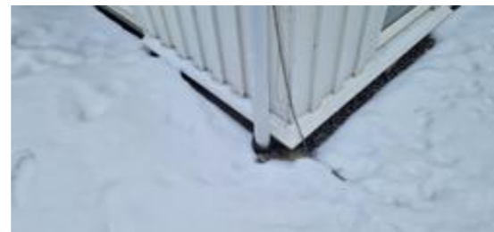
Dårlig lufting/sprekkdannelse
