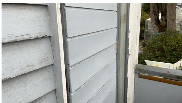
Enkel tett balkongdør.
