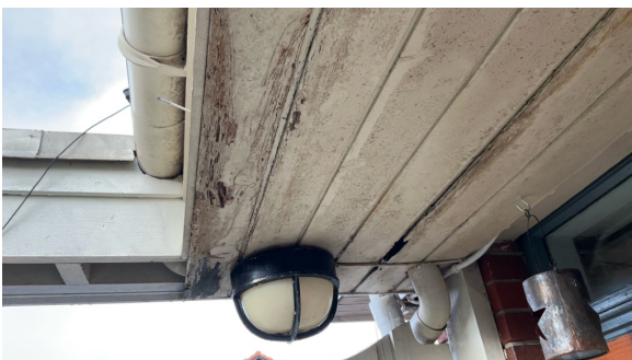
Råteskadet underkledning.
