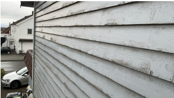
Overflate før behandling.
