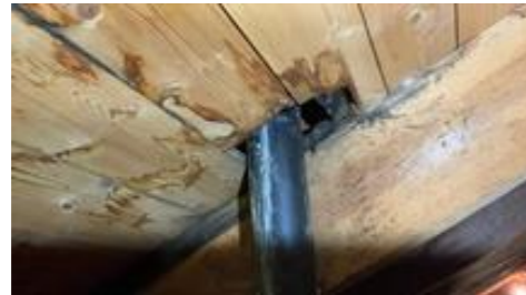
Fuktskjolder rundt gjennomføring.
