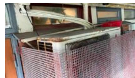
Utedel underetasje rustet.
