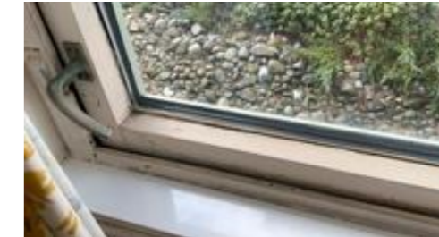
Eldre vindustype med begrenset tetting mellom karm og pakning.
