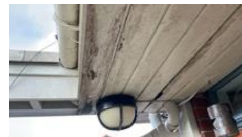
Råteskadet underkledning.
