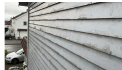
Overflate før behandling.
