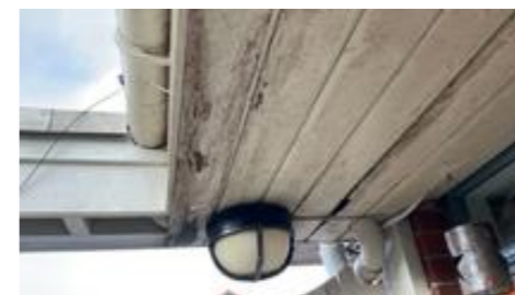
Råteskadet underkledning.
