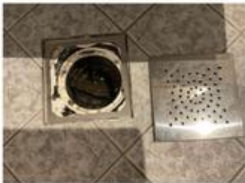
Hovedsluket uten membran i klemring
