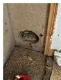
Hulltaking på yttervegg mot nord-vest
