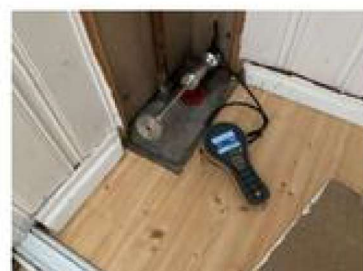
Måling med pigger i vegg mot terreng
