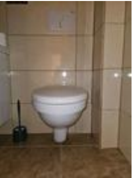
Det er ikke tiltak for lekkasjesikring i tilknytning til vegghengt wc
