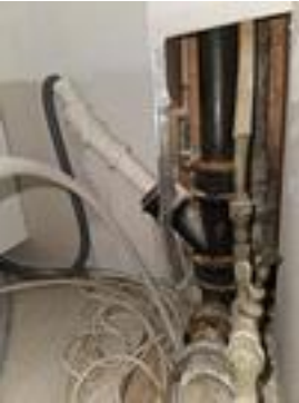
Vann- og avløpsrør under kjøkkenbenken. Det lodrette røret er felles rørstamme.
