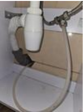
Det er ikke tiltak for lekkasjesikring i tilknytning til vegghengt wc
