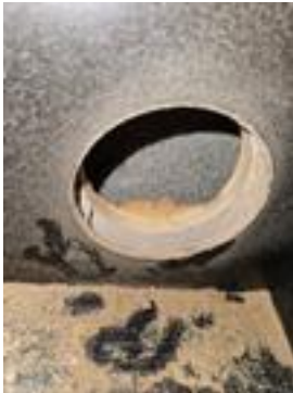
Borret hull fra soverommet, men fant betongvegg bak kledningen
