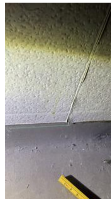
Eksempelbilde av løst belegg i skjøter.
