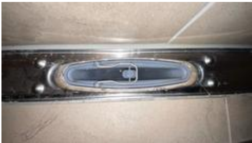
Plastsluk med synlig membran under klemring.
