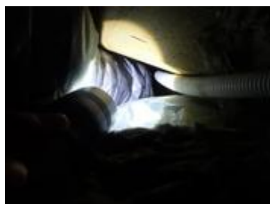
Utett dampsperre ved rørgjennomføringer mot kaldtloft.
